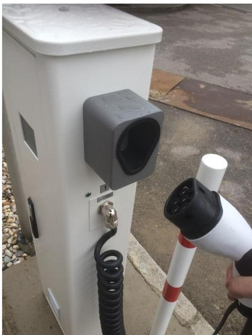
Mit dem Schlüsselschalter, der im Fahrzeug im Handschuhfach liegt, kann bei Bedarf die Tankstelle vor dem Tanken ein- und danach wieder ausgeschaltet werden. Damit wird verhindert, dass fremde Fahrzeuge die Tankstelle nutzen können.
